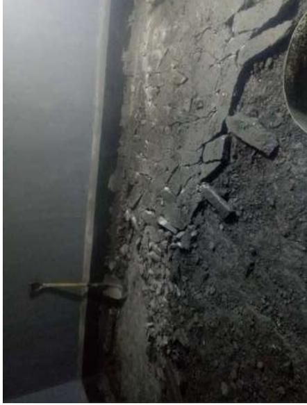
DEMOLICION DE LOSA EN EL INTERIOR DE CAMARA DE
